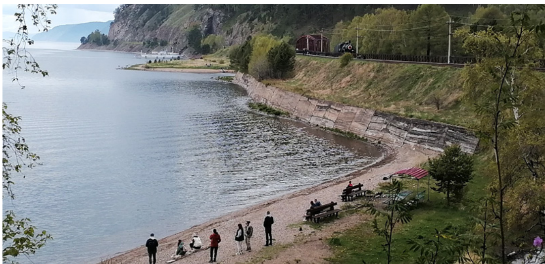
Рис. 2. Обследование берегозащитных сооружений Кругобайкальской железной дороги.
